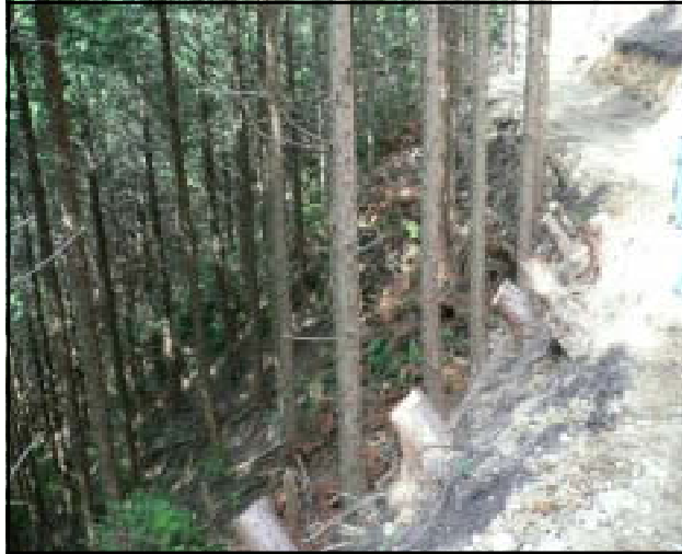
土留めを兼ねて固定した切り株
