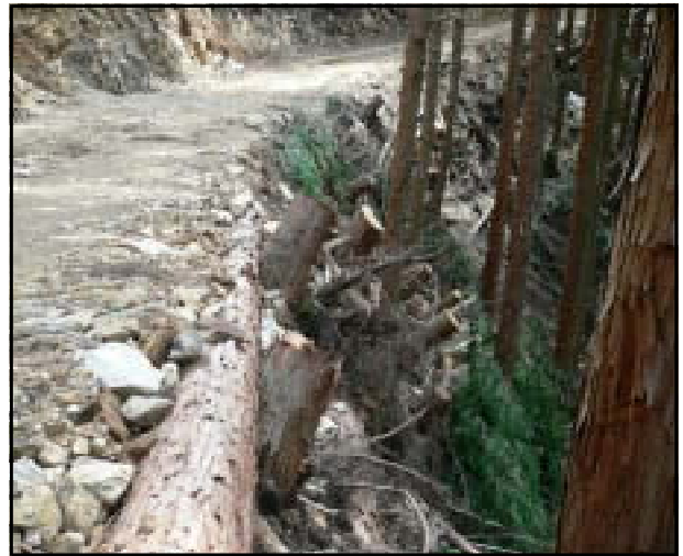
固定した切り株に丸太を渡して簡易に路肩保護
