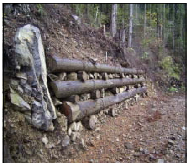
路体の弱いところには間伐木の丸太組で補強
